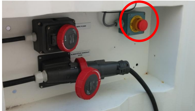
Figure 3: Localisation de l'arrêt d'urgence externe de l'unité
