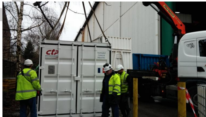
Figure 4: Déchargement de l'unité mobile de déshuilage
