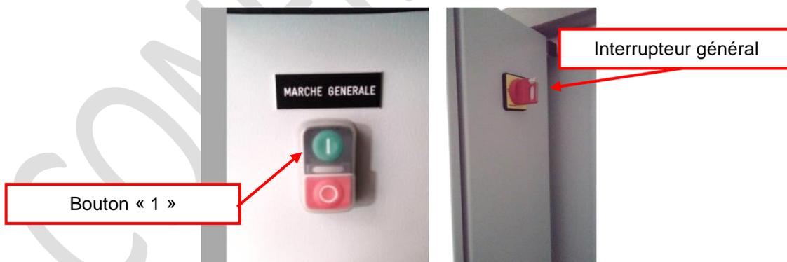
Figure 5 - Vue de l'armoire électrique
