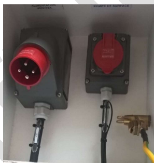
Figure 10: Niche électrique pour raccords
