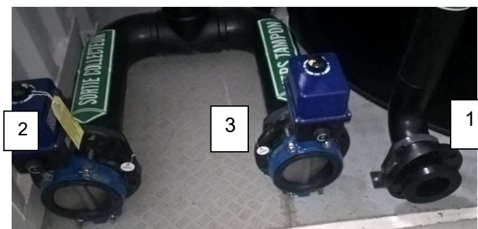
Figure 9: Vue des raccords hydrauliques du NEUTRAMOBIL® et identification
