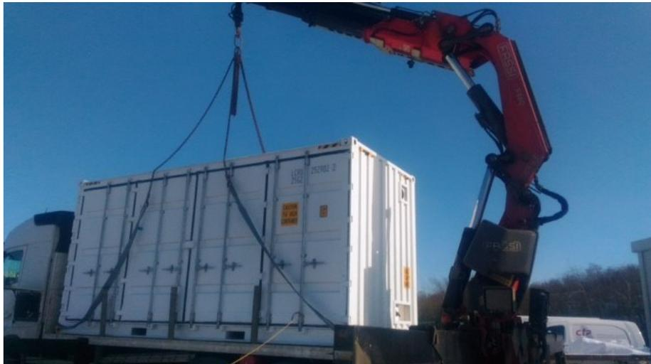
**Figure 6: Levage par les coins « ISO » inférieurs du container à l'aide d'élingues**
