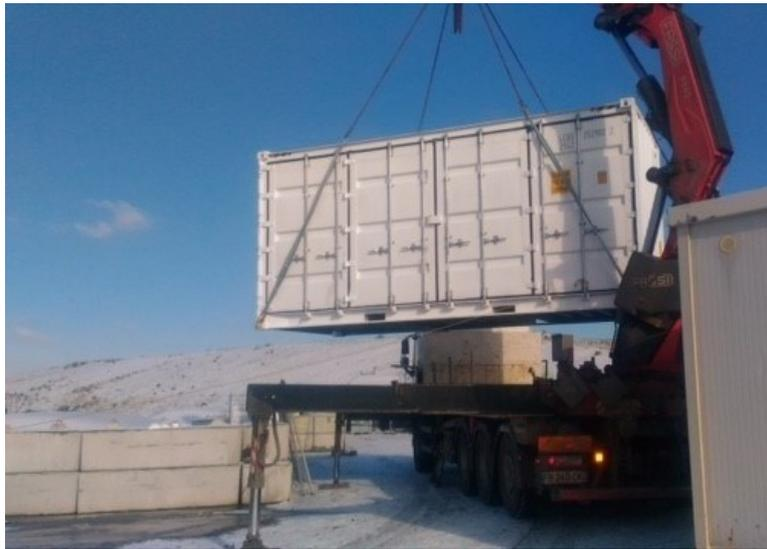
**Figure 3 : Exemple de levage 20 pieds HC open side par les 4 coins ISO du bas**
