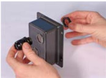
3. Serrez les presse-étoupes à 2,5 Nm avec une clé de 21 mm, pour assurer l'étanchéité. Si vous utilisez un presse-étoupe différent, celui-ci doit impérativement assurer une étanchéité à l'eau IP66.
