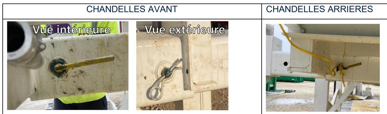
**Figure 52 : Positionnement des axes-goupilles des chandelles**
