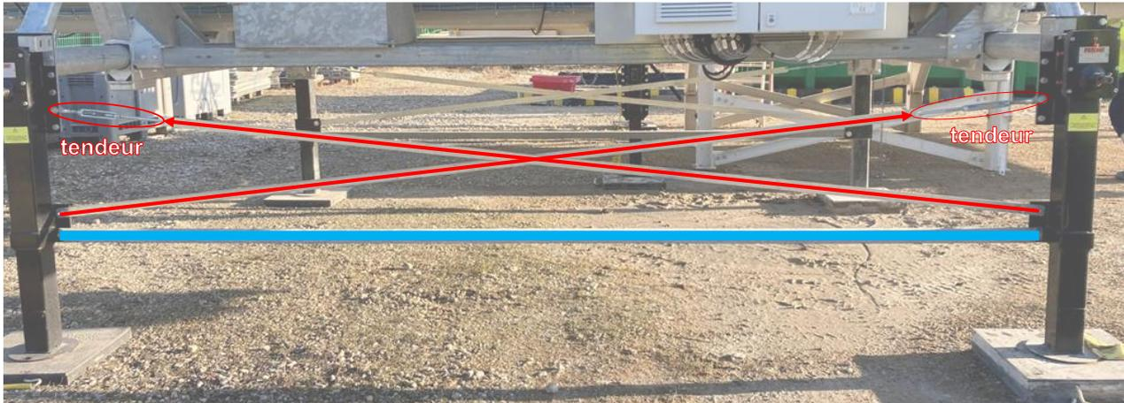
Figure 34 : Mise en place des contreventements du silo
