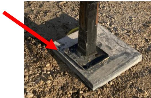
Figure 28 : Positionnement des plaques de répartition sous les chandelles
