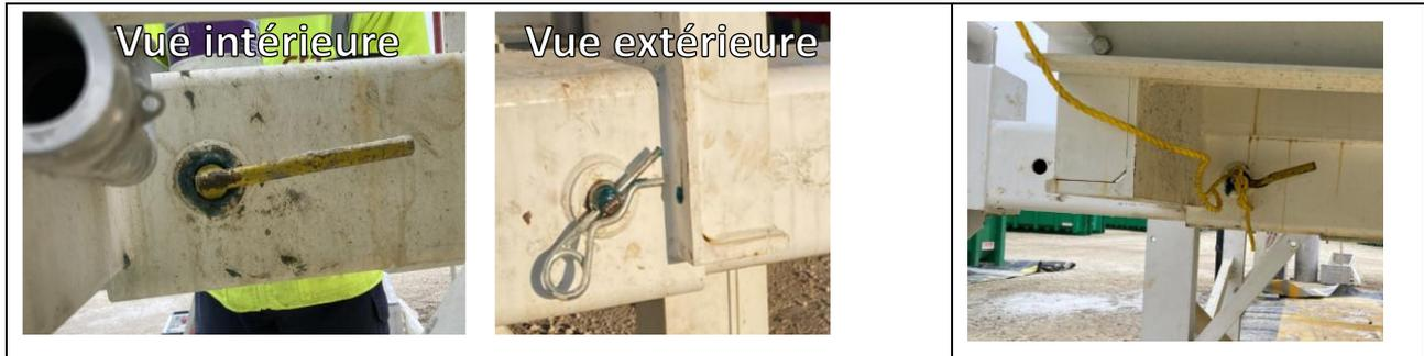
Figure 27 : Positionnement des axes-goupilles des chandelles
