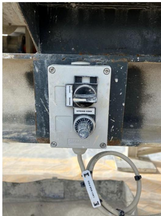
**Figure 4. Boîte de commande trépied motorisé**
