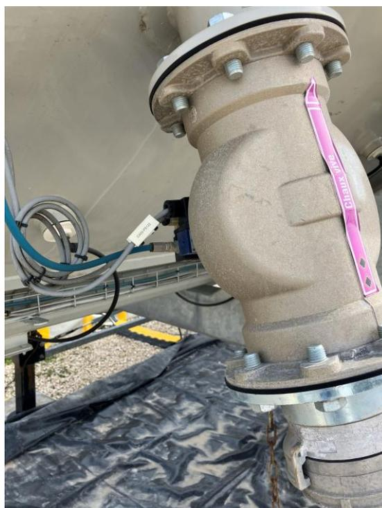
**Figure 15. Vanne de remplissage en chaux**
