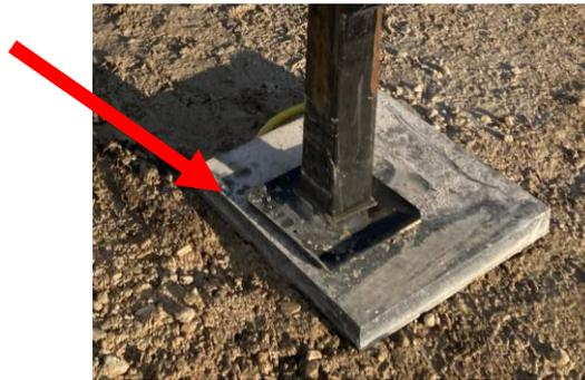
**Figure 53 : Positionnement des plaques de répartition sous les chandelles**
