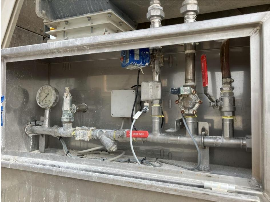
**Figure 11. Coffret de distribution réseau BP**
