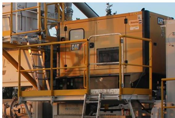
Figure 36 : Passerelle du GE en config production
